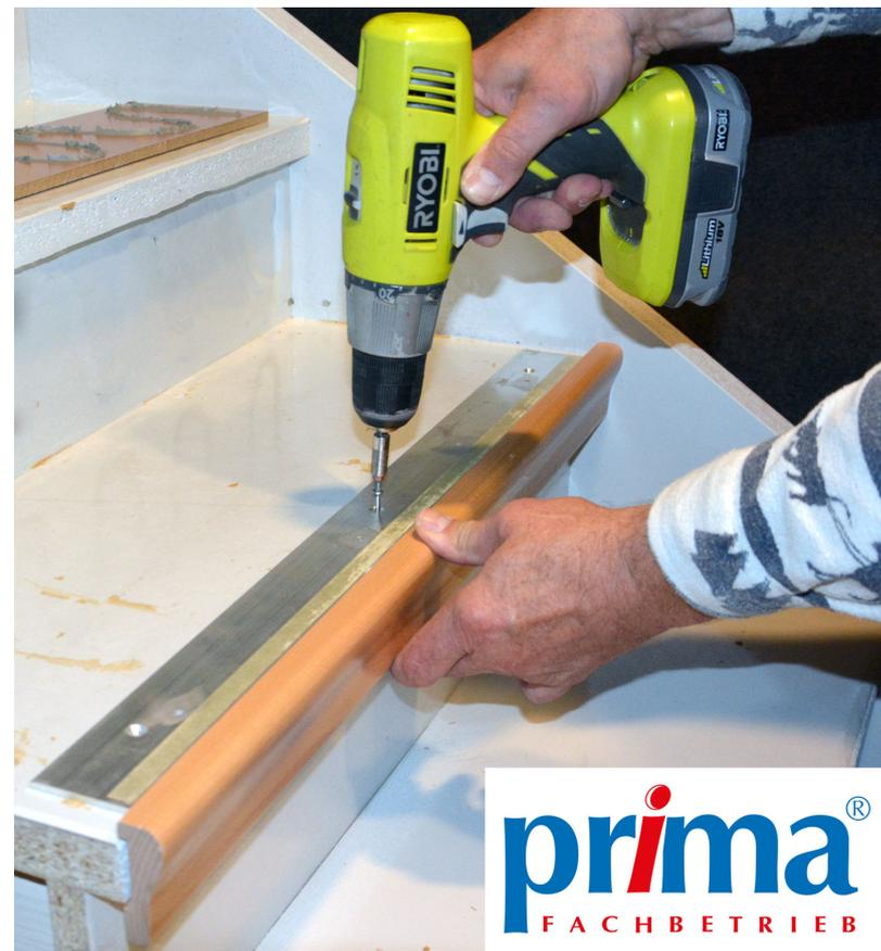
d.) jetzt die Trittstufe Breite/Länge ausmessen. Bei der Tiefe der Trittstufe, bis zur Kante der angebrachten Echtholzvorderkante ausmessen, bitte hier 3 mm für das Antirutschprofil abziehen.
