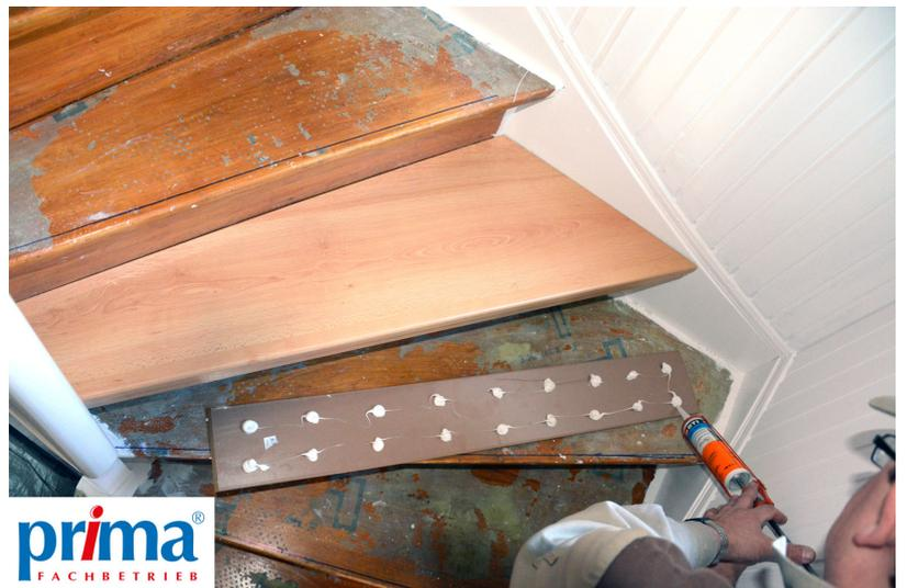
Jede Stufe prüfen, ob alles richtig aufgeklebt ist und sitzt. Wenn alles in Ordnung ist, ein Gewicht (Stufe abdecken nicht vergessen) auf die Trittstufe stellen, damit während des Klebprozesses die Stufe sich nicht verschiebt und in Form bleibt.
